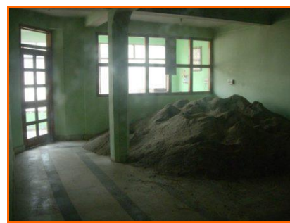
Au rez-de-chaussée, la future salle de classe (commune).
